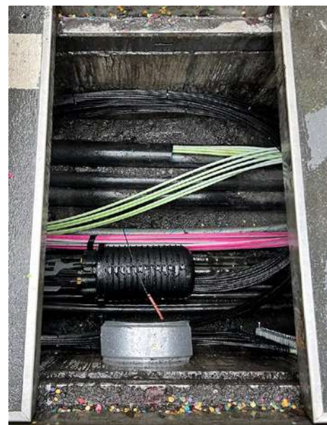
Vom Herzstück bis zur Hausanschlussleitung: Links laufen im PoP alle Glasfasern zusammen. Oben führen sie im Untergrund weiter zu den Gebäuden.
