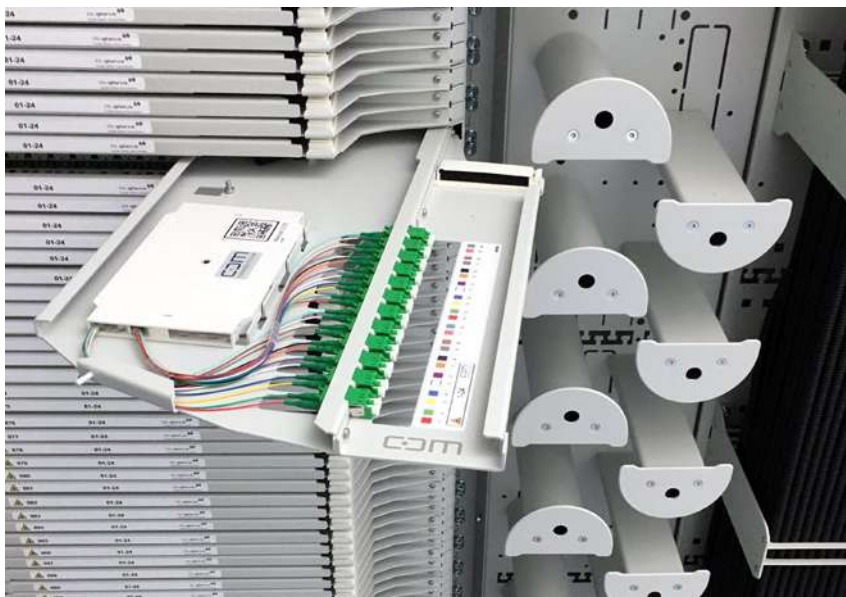
Vom Herzstück bis zur Hausanschlussleitung: Links laufen im PoP alle Glasfasern zusammen. Oben führen sie im Untergrund weiter zu den Gebäuden.
