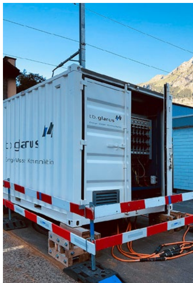
Installation einer mobilen Trafostation.
