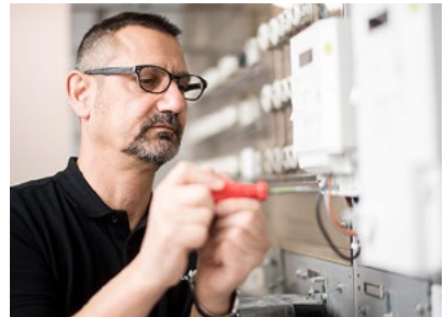
Montage eines neuen «smarten» Zählers.
