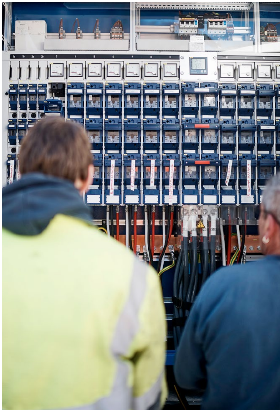
Umbau der Trafostation TS Walchergut.
