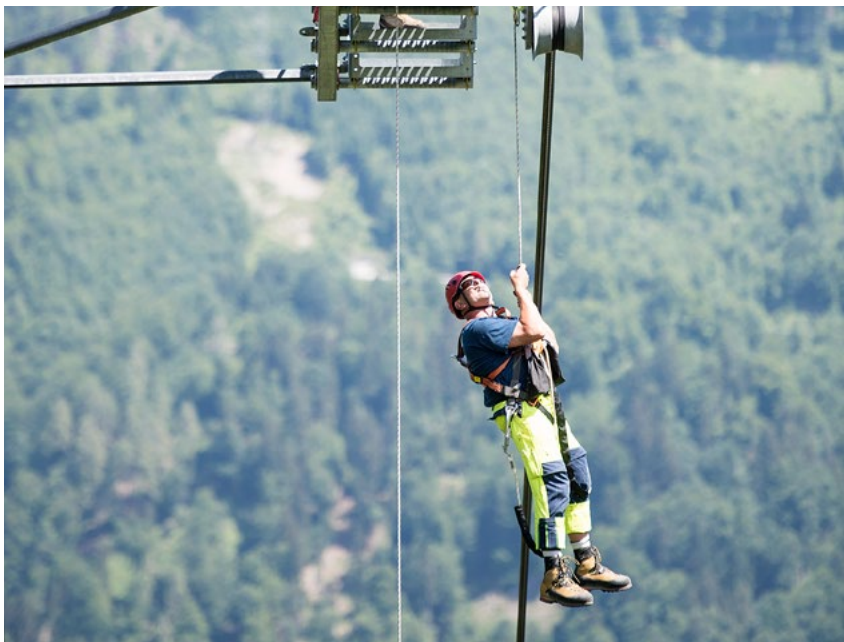
Übung Mastrettung an der Brunnenbergbahn.
