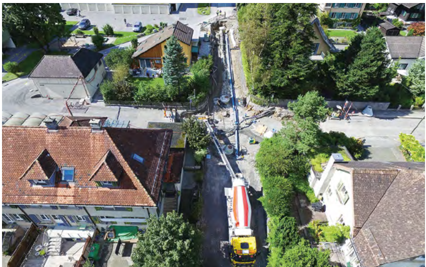
Sicht von oben: Bauarbeiten im Bereich Riedernstrasse-Lurigenstrasse.
