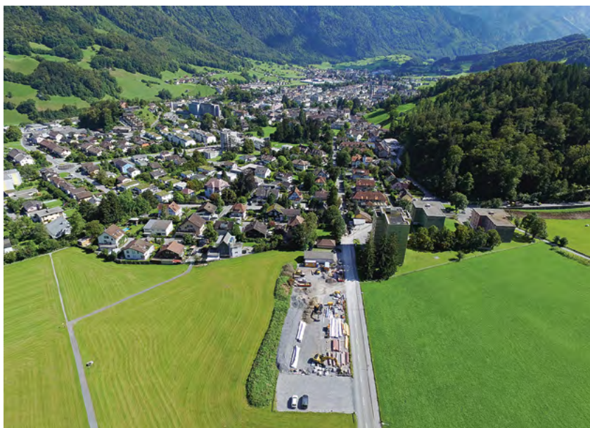
Riedernstrasse mit dem Bauplatz aus der Vogelperspektive.
