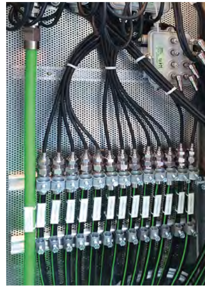
CATV-Versorgung: Hausanschlüsse ab Verteilkabine
