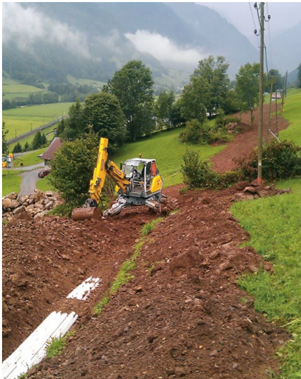
Der neue Rohrblock auf der Teilstrecke Schwanden–Leuggelbach wird durch den Baumeister zugedeckt.
