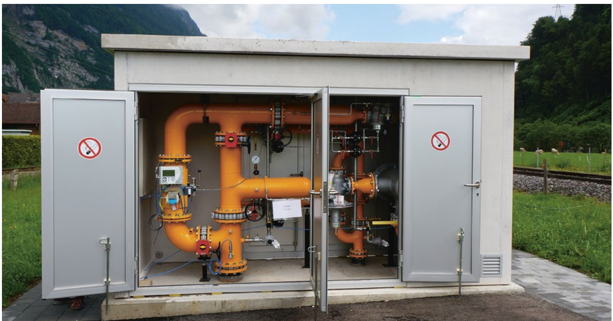
Neubau DRMS (Druckreduzier- und Messstation) Rollengut, Netstal.
